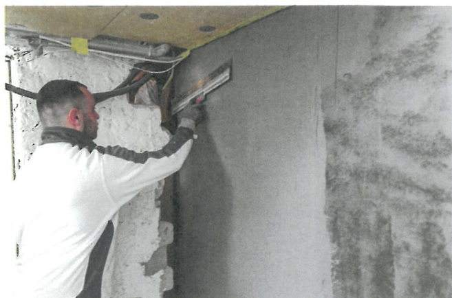
Abb. 4: Innenabdichtung mit FPD
